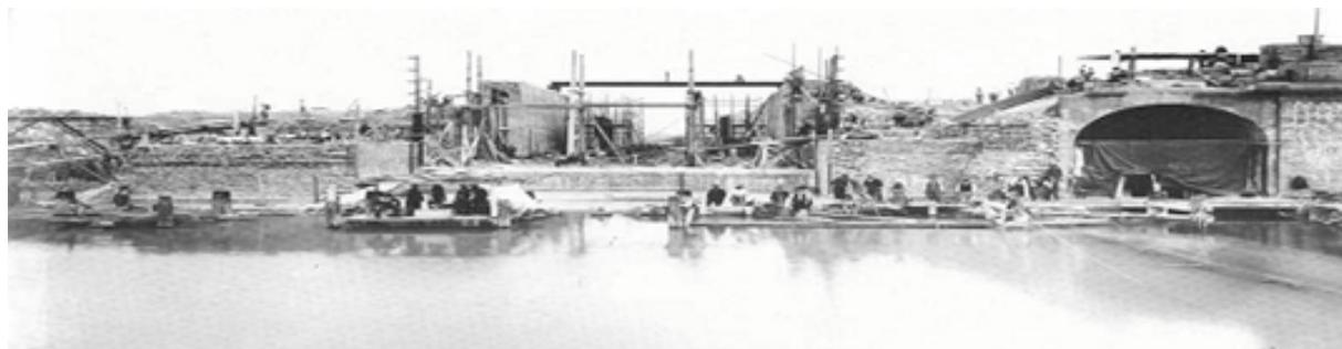
L'usine hydroélectrique de Cusset en construction. Mobilisation de plusieurs centaines d'ouvriers autour de l'usine-barrage. On distingue une conduite forcée d'arrivée d'eau ainsi que l'écluse en cours d'achèvement.
